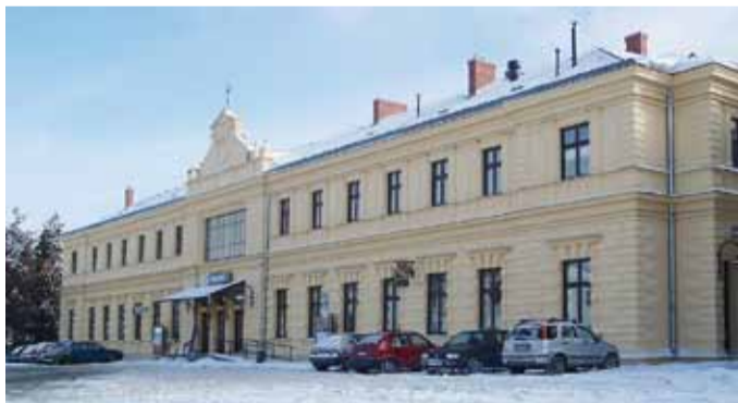
SOUČASNOST. V letech 2002 až 2008 prošla budova rozsáhlou rekonstrukcí, která se týkala střešky, fasády i vestibulu.
