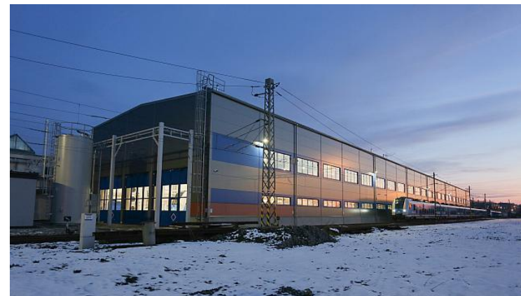
Opravárenská hala BRNO-MALOMĚŘICE
