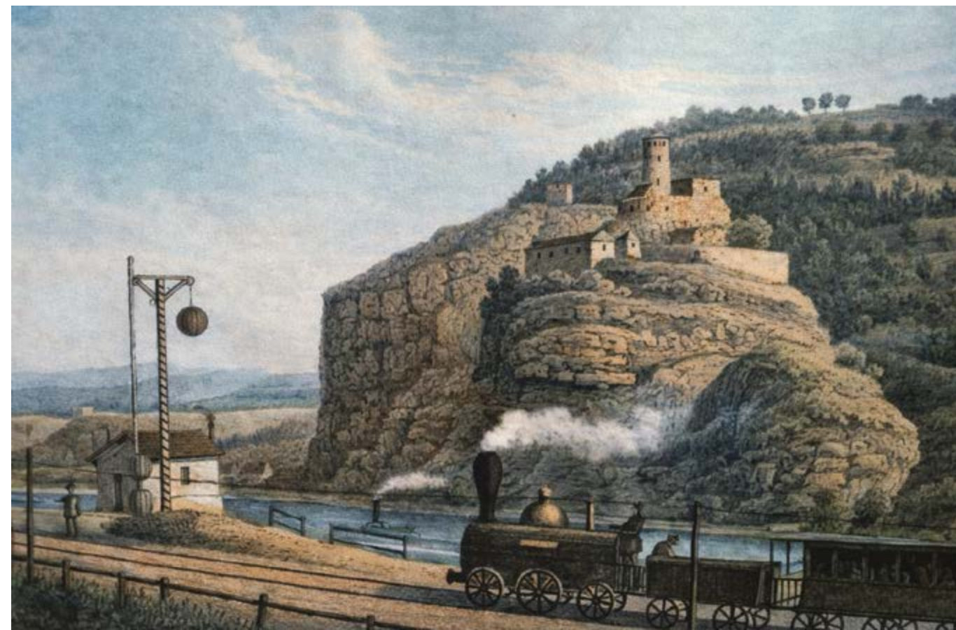
Košové návěstidlo na trati Praha - Ústí nad Labem vyobrazené na malbě, která je ke zhlédnutí na hradě Střekov.
