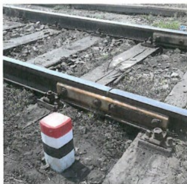
Obr. 2 umístění návěstidla k upozornění na hranici izolovaného úseku
